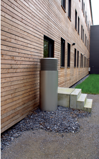
Ansaugöffnung für kontrollierte Wohnraumlüftung (mindestens 80 cm über Boden)
