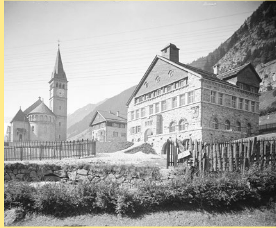
Schulhaus, Pfarrhaus und Pfarrkirche, um 1915
