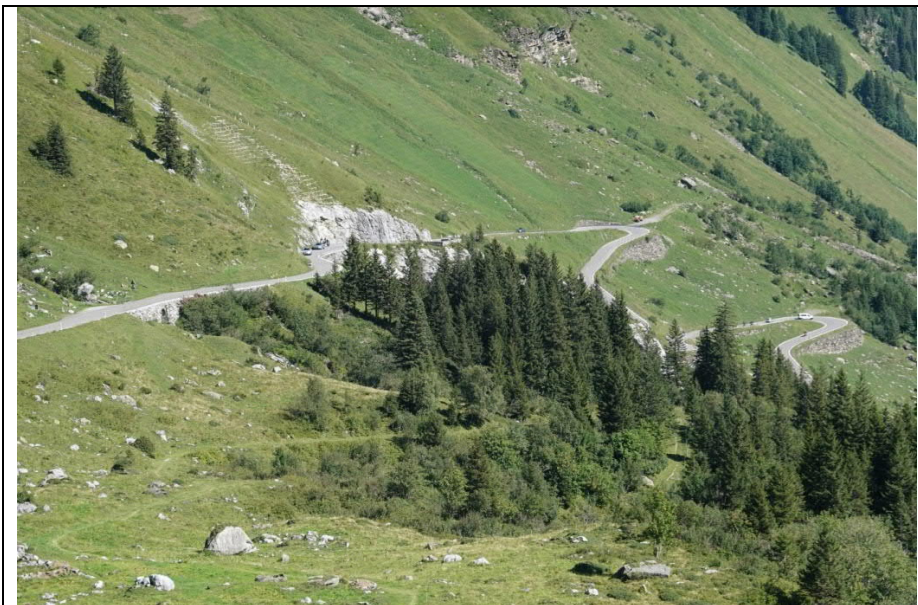
Ansicht auf die Serpentina oberhalb von der Jägerbalm. Aufgrund der wechselnden Geologie, ändert auch die Gesteinsart mit der die Stützbauwerke ausgeführt sind. Klausenpass (K14)
