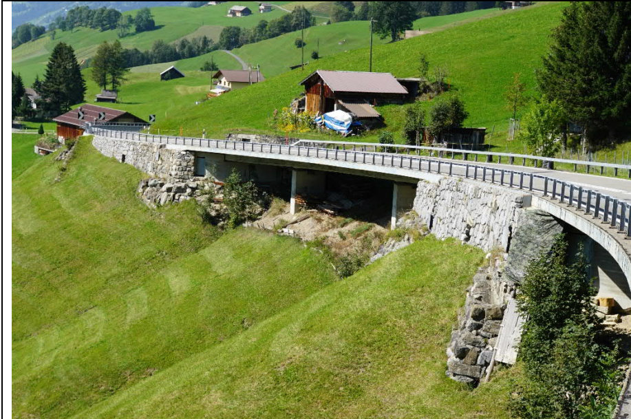
Lehnviadukt bei Ritzen, Ansicht talseitig Klausenpass (K76)
