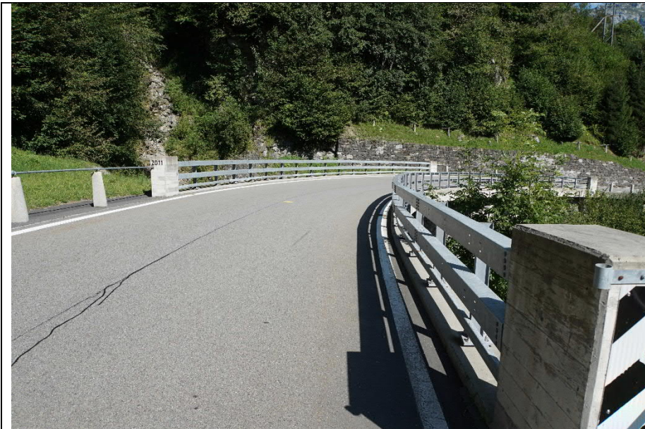
Brücke bei Weidli, Strassenraum. Die Abgrenzung der Brücke ist anhand der Änderung des Strassenanschlusses ist klar erkennbar. Klausenpass (K81)
