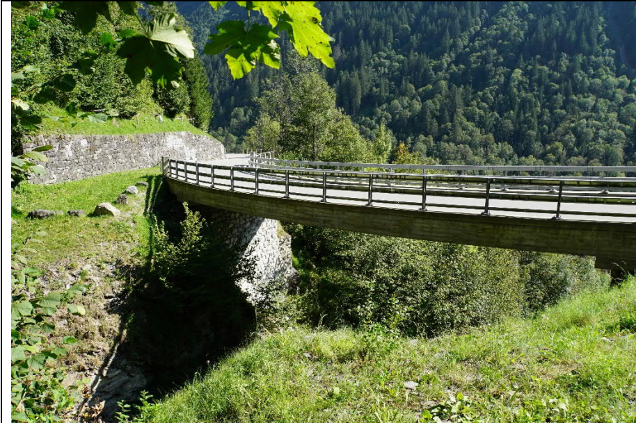
Brücke bei Weidli, Ansicht oberwasserseitig Klausenpass (K81)
