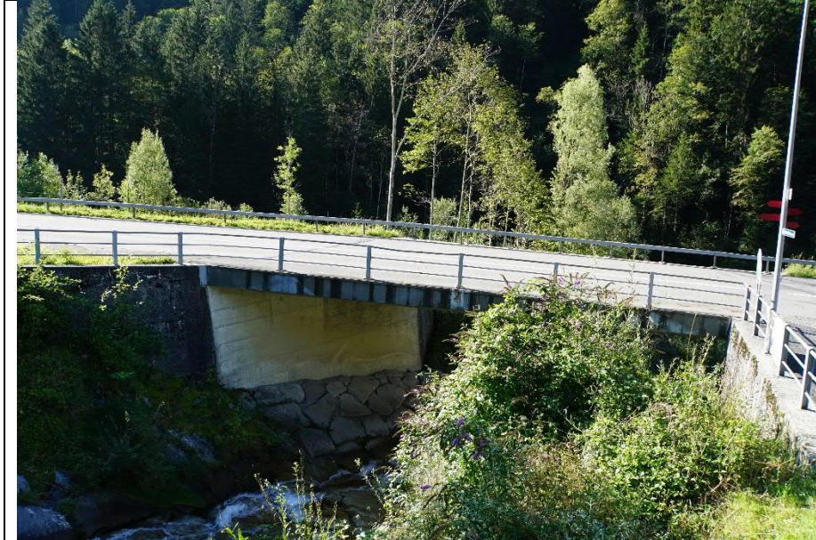
Brücke bei Winterschwand Ansicht oberwasserseitig Klausenpass (K39)
