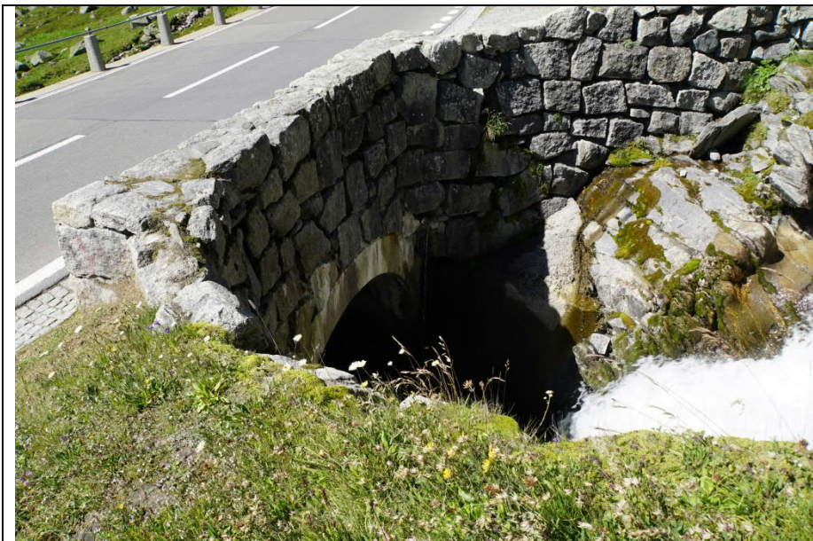
Tiefenbachbrücke Ansicht oberwasserseitig Die Brüstungsmauern sind entlang der Strasse als Natursteinmauerwerk und seitlich als Trockenmauerwerk ausgeführt. Furkapass (F26)
