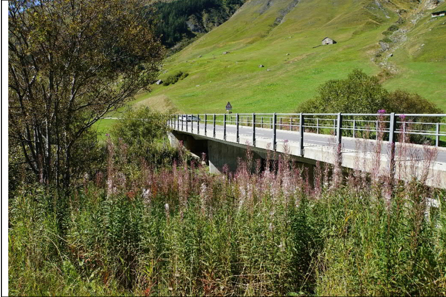
Ansicht Oberwasserseite Urseren (U24)
