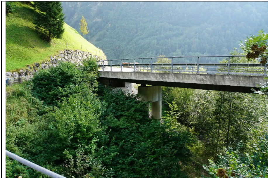
Ansicht Brücke Oberwasserseite Klausenpass (K84)
