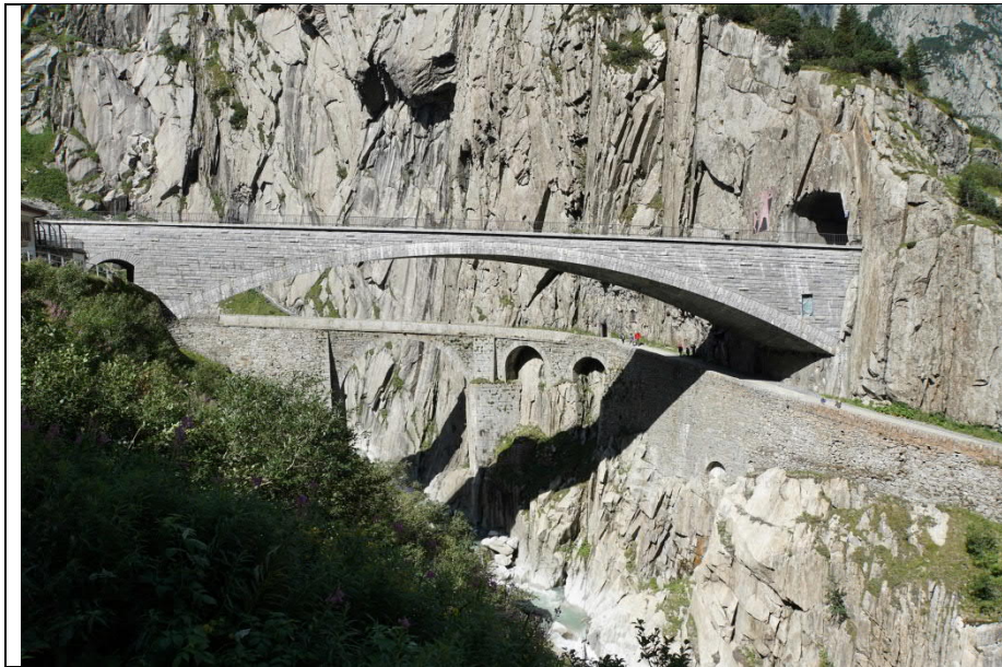
Neue Teufelsbrücke, Ansicht unterwasserseitig Gotthardpass (G10)
