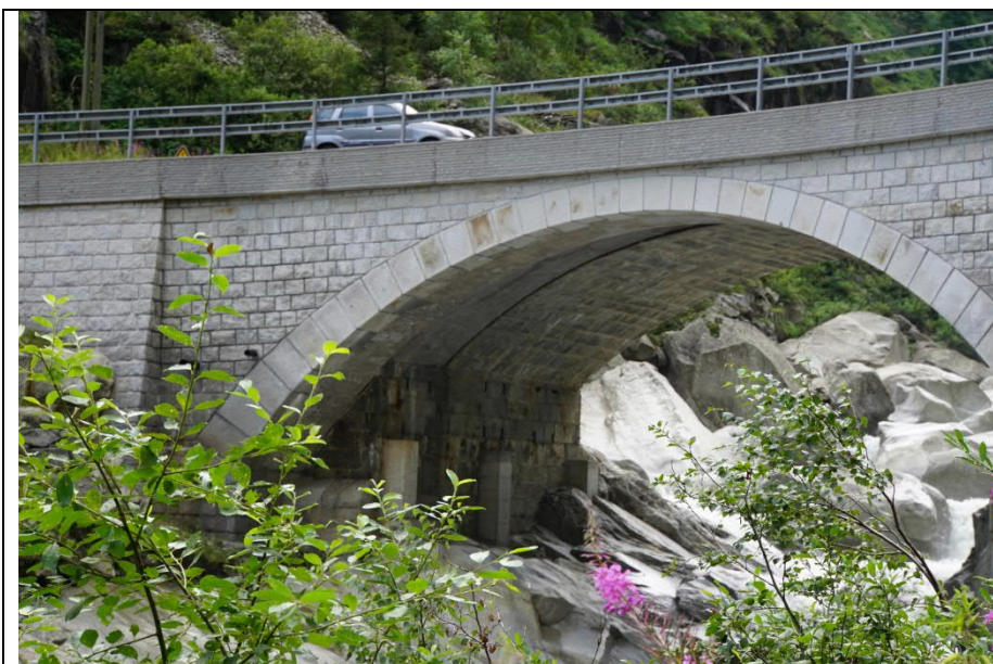
Spränggibrücke, Detail Bogen. Gotthardpass (G4)
