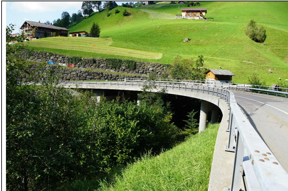
Brücke Ansicht Unterwasserseite Klausenpass (K84)
