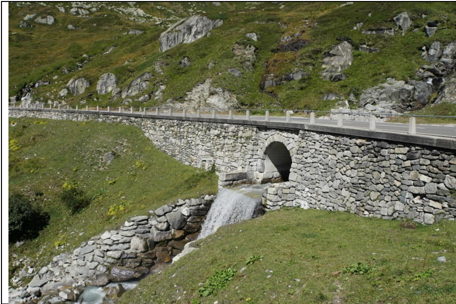
Tiefenbachbrücke, Ansicht unterwasserseitig Furkapass (F26)
