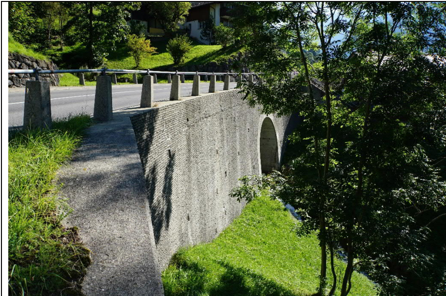
Brücke bei Rüti Ansicht unterwasserseitig Klausenpass (K51)
