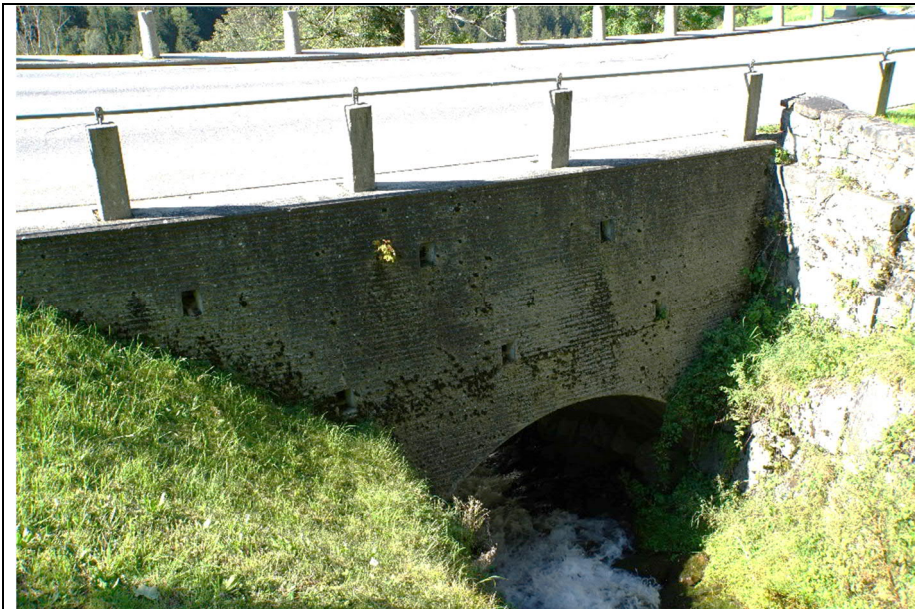
Brücke bei Rüti Ansicht oberwasserseitig Klausenpass (K51)
