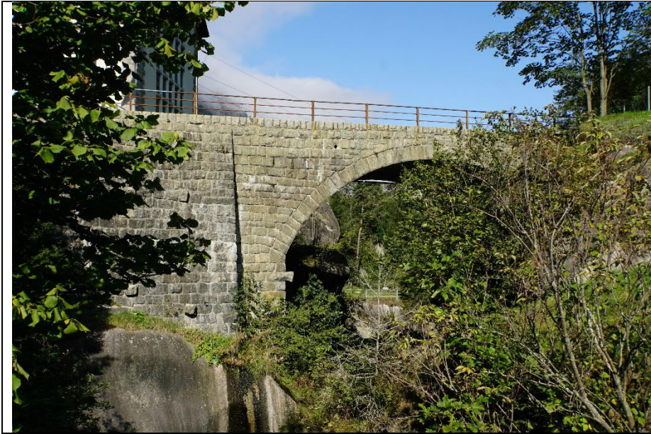
Pfaffensprungbrücke über die Reuss, Ansicht oberwasserseitig. Die Bogenbrücke besteht aus einem Betongewölbe mit Steinverblendung und beidseitigen Eisenröhrengeländern. Amsteg-Göschenen (AG28)
