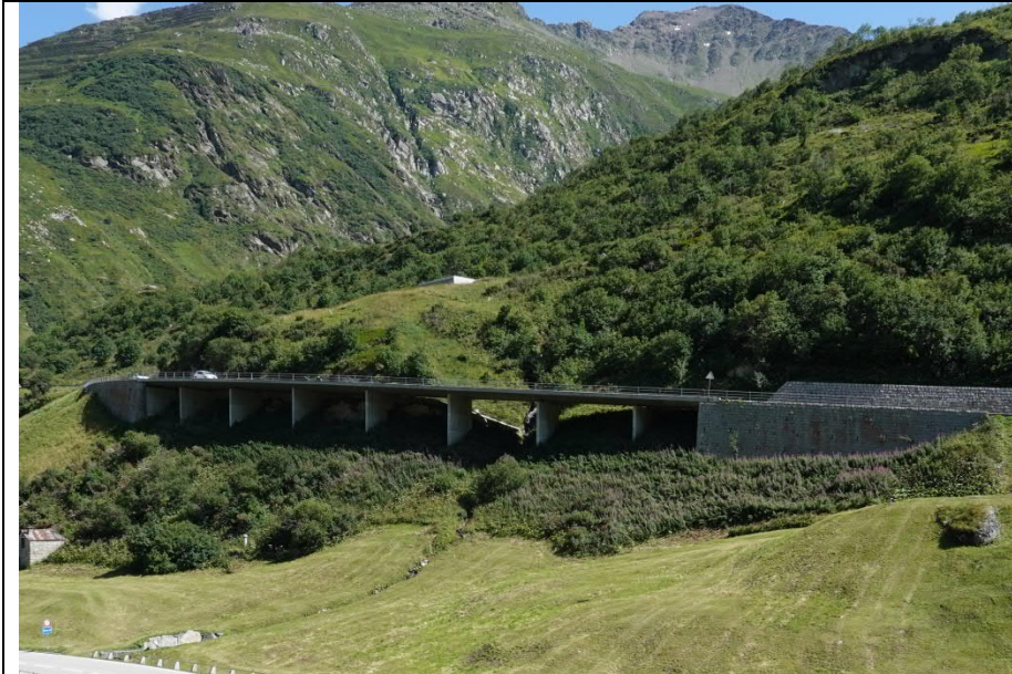
Ansicht talseitig Gotthardpass (G27)
