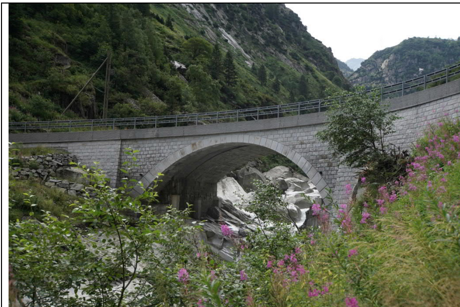
Spränggibrücke, Ansicht unterwasserseitig. Gotthardpass (G4)
