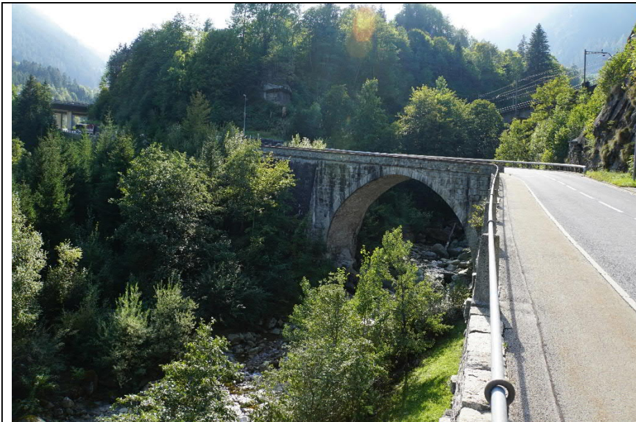
Mühlebrücke über die Meienreuss bei Wasen, Ansicht unterwasserseitig. Die historische Steinbogenbrücke wurde bei einem Unwetter im Jahr 1987 zerstört und im Jahr 1991 nach alten Plänen wiederaufgebaut. Die Brücke wird beidseitig von einer gemauerten Brüstung begrenzt. Die Brücke stellt ein gelungenes Beispiel für den Wiederaufbau eines historischen Bauwerks dar. Amsteg-Göschenen (AG32)
