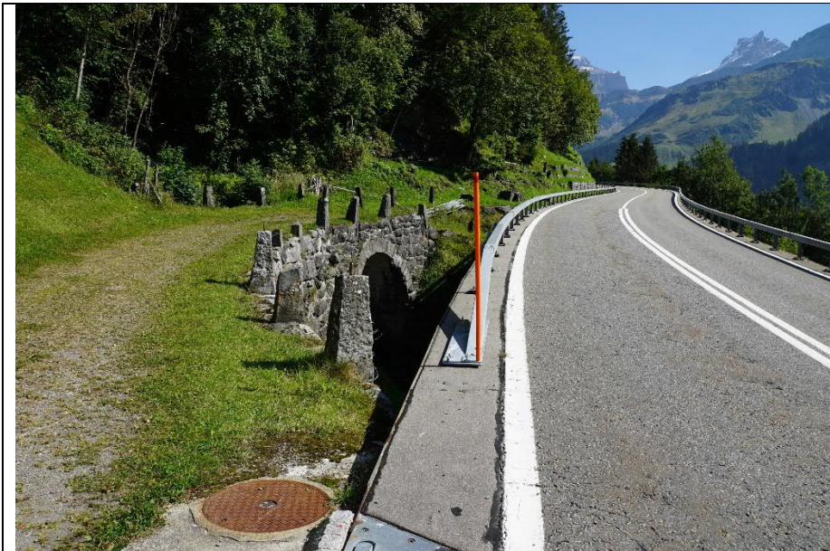
Lehnviadukt bei Ritzen Strassenraum, mit den bergseitig noch vorhande- nen historischen Bauwer- ken. Klausenpass (K76)
