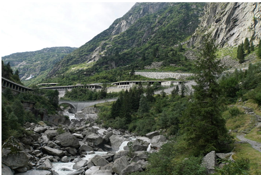
Gotthardpass (Schöllenen): gelungene Neugestaltung mit Galerien, Naturstein-verkleideten Stützmauern, Bogenbrücke im Kurvenradius, Steinschlagsicherung.
