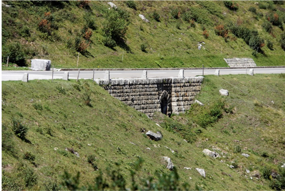
Gotthardpass (oberhalb Mätteli): aus Hausteinen gemauerter, überwölbter Durchlass aus örtlichem Granit; die Kolonnensteine sind in den nur wenig hervortretenden Kor-don der Mauerkrone eingelassen.
