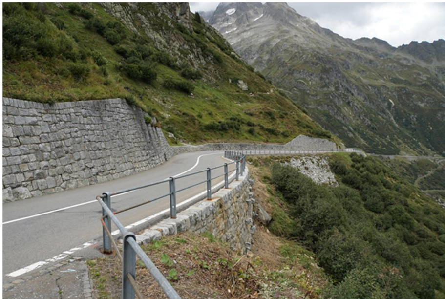
Sustenpass : einheitlich durchgestaltete Touristenstrasse, in diesem Abschnitt mit originalem Stahlrohrgeländer.
