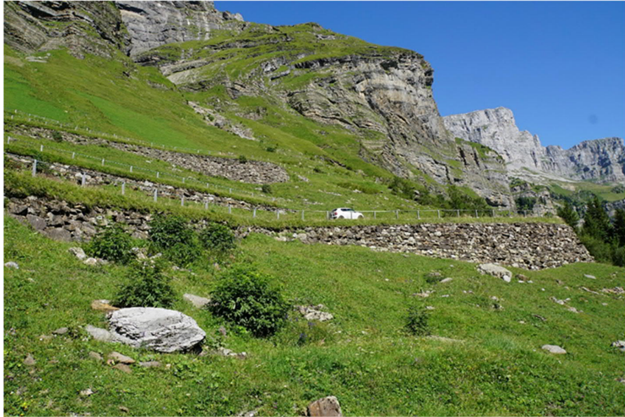
Klausenpass : übereinander gestaffelte Serpentinien mit Trockenmauern, deren Bruchsteine aus einem nahegelegenen Steinbruch stammen; (möglicherweise jüngeres) Stahlrohrgeländer.
