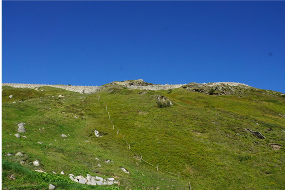
Furkapass : Natursteinmauern mit Kolonnensteinen in Untersicht.
