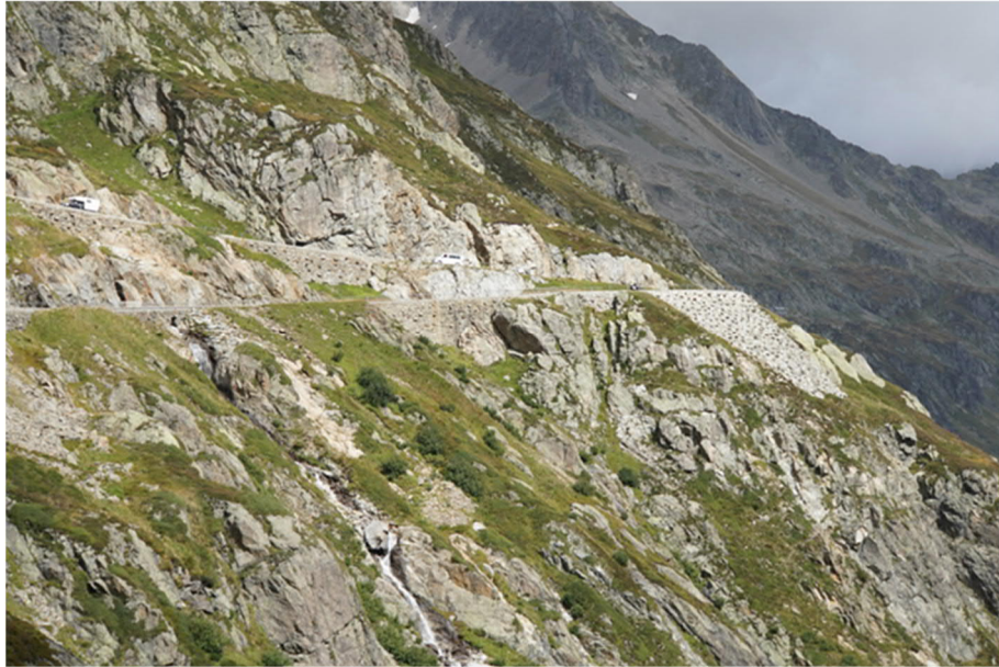
Sustenpass : Wendeplatte in der Meienwang mit feinstrukturierten rollierten Böschungen.
