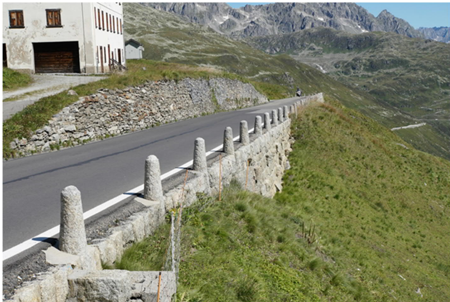
Furkapass : hangseitig eine Trockenmauer aus Bruchsteinen, talseitig eine gemörtelte Bruchsteinmauer, konische Kolonnensteine mit ringförmigem Abschluss, eine Form, die der späteren Bauzeit entspricht.
