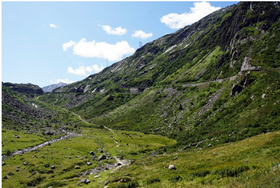
Gotthardpassstrasse beim Brüggloch: in den Felshang eingeschnittene Trasse.
