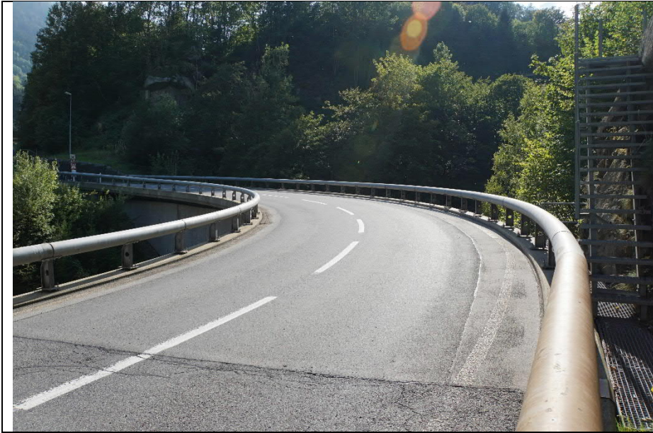
Massives Stahlröhrengeländer bei der neuen Mühlebrücke bei Wasen. Amsteg-Göschenen (AG33)
