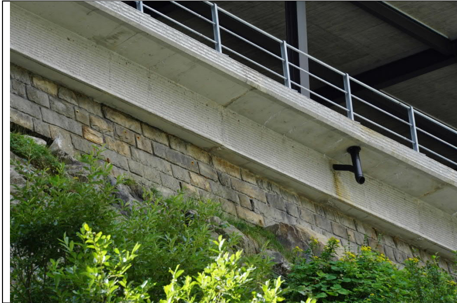
Talseitiger Abschluss der Galerie Brüggwaldboden Gotthardpass (G13)
