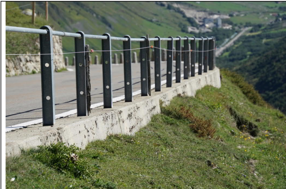
Talseitiges Geländer auf einem Betonriegel oberhalb von Realp. Furkapass (F15)
