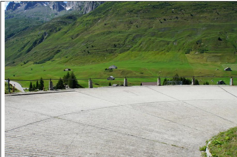
Kolonnensteine mit einem Eisenröhrengeländer bei der Wendepfanne oberhalb von Hospental. Gotthardpass (G26c)
