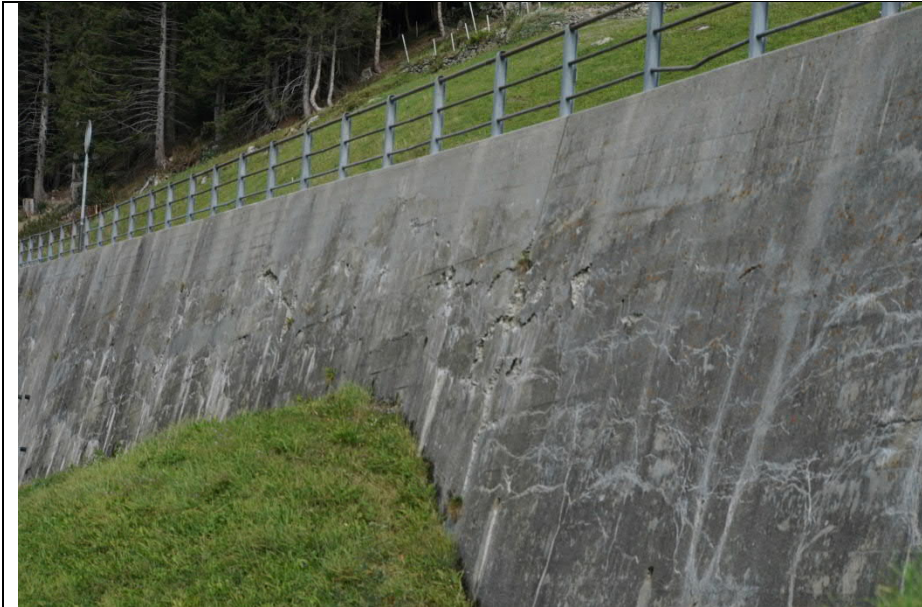
Geländer auf einer Stützmauer bei Schwaltenrain, Sustenpass (S13b)
