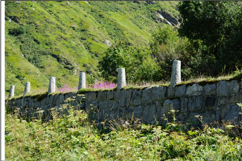
Historische Kolonnensteine aus der Bauzeit der Kunststrasse am Gotthardpass oberhalb von Hospental. Gotthardpass (G26a)
