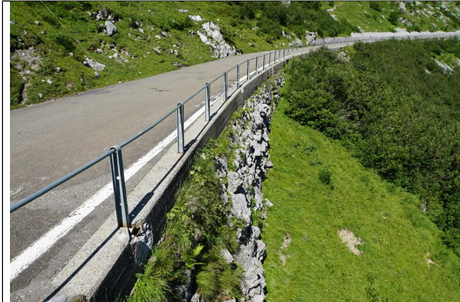
Talseitiges Gelände auf einem Betonriegel oberhalb von Wild Boden. Klausenpass (K11)
