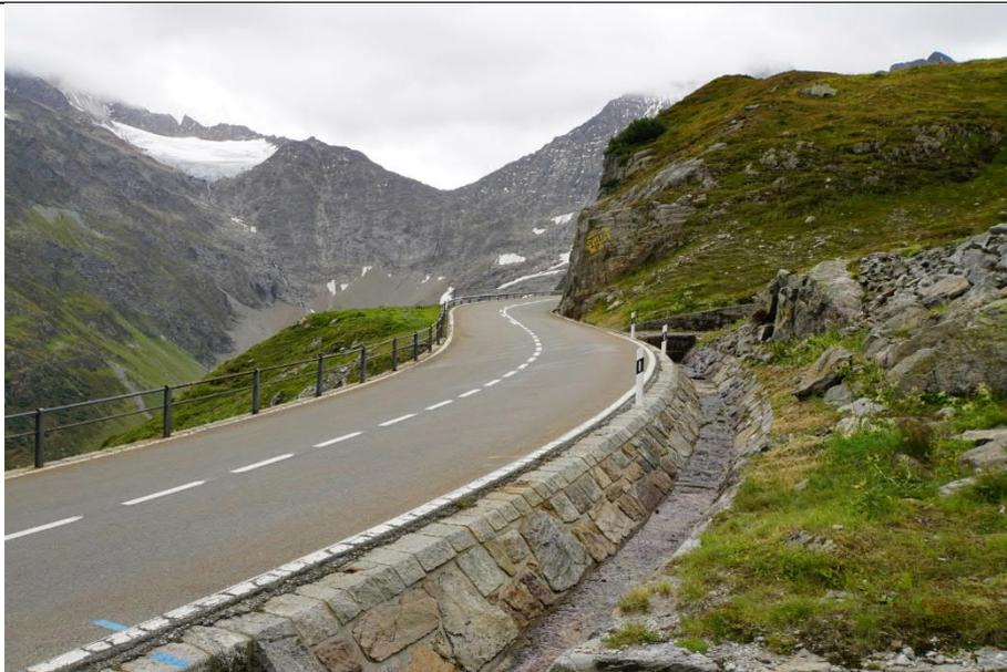
Bergseitig, gepflästeter, strassenparalleler Wassergraben unterhalb der Passhöhe. Der verhältnismässig tiefe Sammelgraben führt Hangwasser einem Bachdurchlass zu. Schönes Beispiel für die sorgfältig gestaltete Ausführung der Entwässerungen an der Sustenstrasse.
