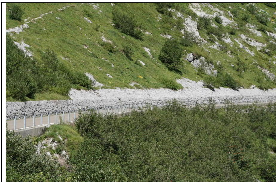
Rollierte Böschungen oberhalb einer Stützmauer unter- halb von Vorfurtt. Das bergseitige Bau- werk ist ohne «Useluegi» ausge- führt. Klausenpass (K11)
