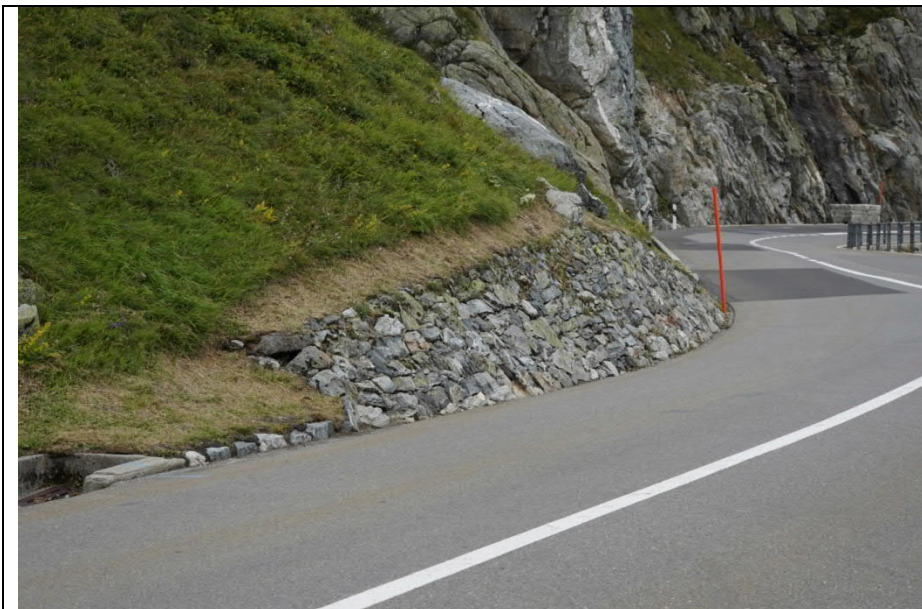
Bergseitige rollierte Böschungen unterhalb des Scheiteltunnels. Das bergseitige Bauwerk ist ohne «Useluegi» ausgeführt, die in dieser Lage zu Schäden an den Fahrzeugen führen würden. Sustenpass (S24)
