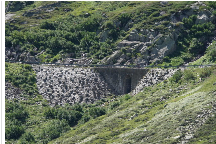
Rollierte Böschungen seitlich der Brücke unterhalb des Brüg- glochs. Gotthardpass (G19)
