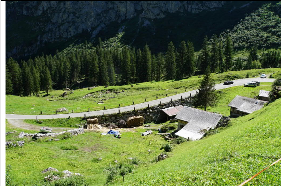
Damm bei der Jägerbalm. Der Geländesprung wird beidseitig mit einer grosskalibrigen Naturstein-Trockenmauer gesichert. Klausenpass (K15a)
