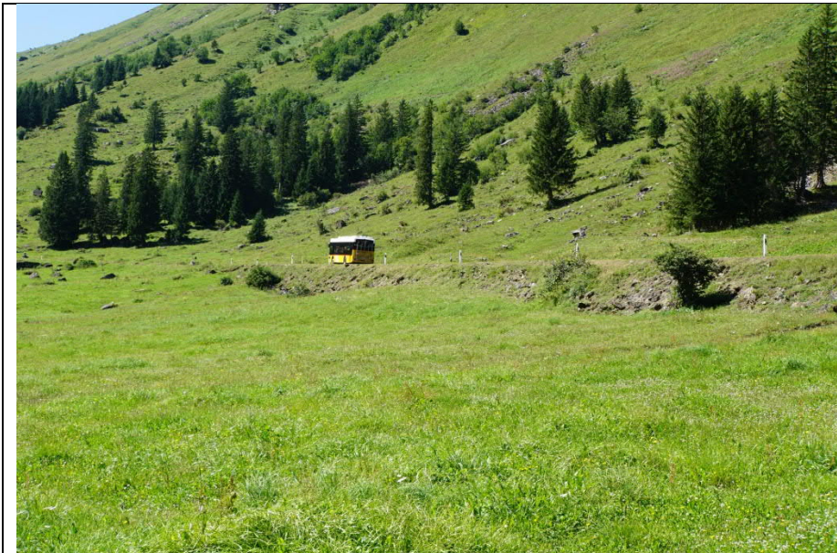
Damm bei Oberst Wang. Bewachsene rollierte Böschung. Klausenpass (K18)
