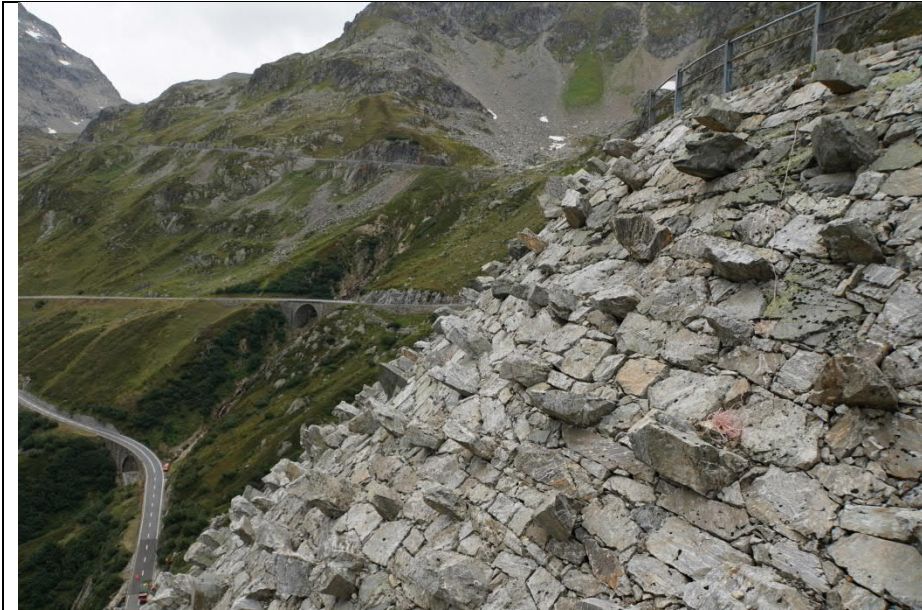
Detail einer rollierten Böschung unterhalb des Scheiteltunnels Sustenpass (S27a)
