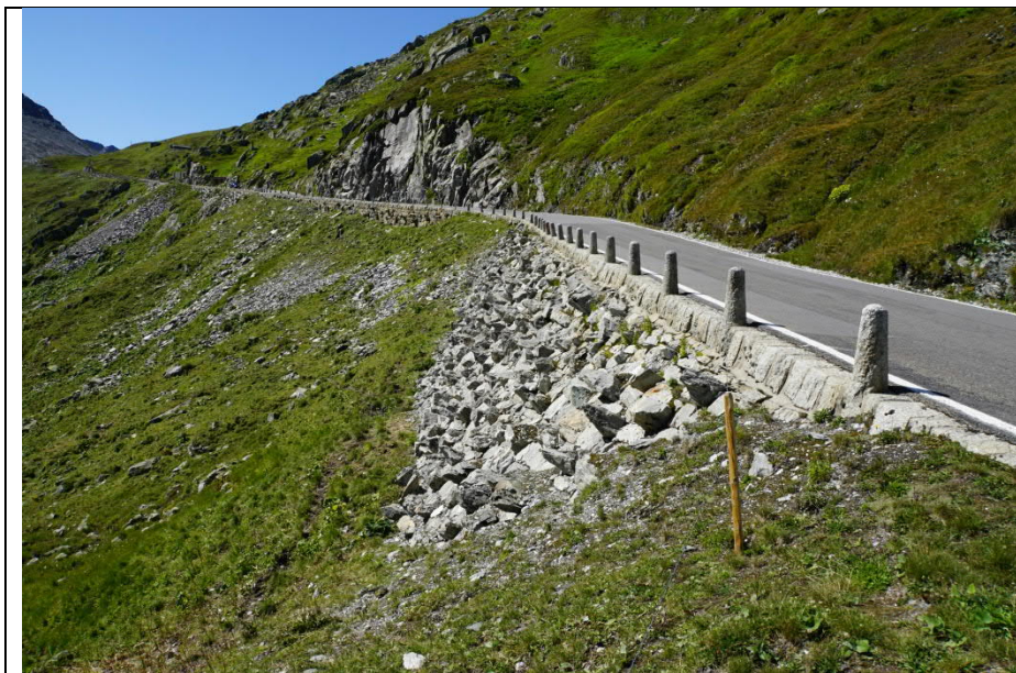
Rollierte Böschungen oberhalb vom Side- lenbach. Furkapass (F30a)
