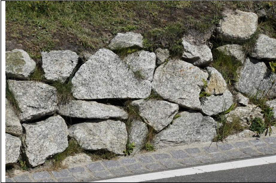
Bergseitige Stützmauer beim Hotel Galenstock. Detail Mauerwerk. Furkapass (F22)
