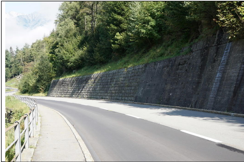
Bergseitige Stützmauer vor Gurtnellen. Die Stützmauer ist teilweise mit Quadersteinen verblendet. Amsteg Göschenen (AG25)
