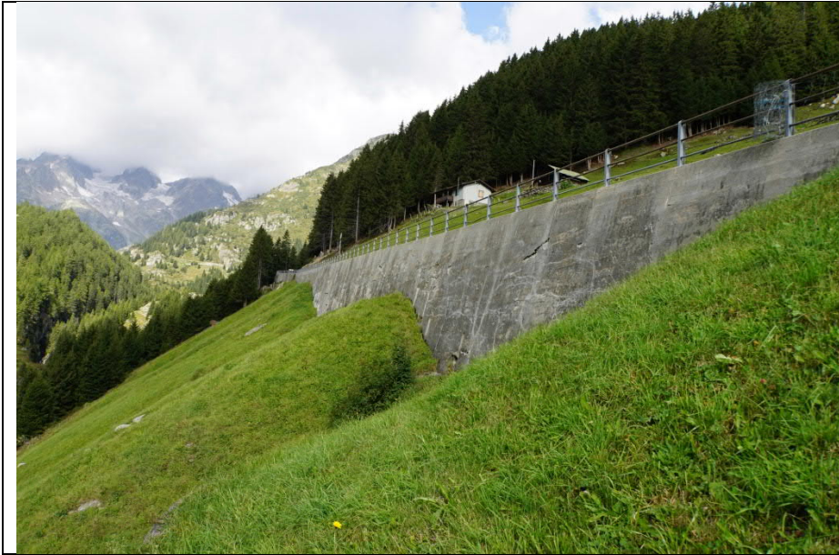
Talseitige Stützmauer, beim Schwahntenrain. Sustenpass (S13b)
