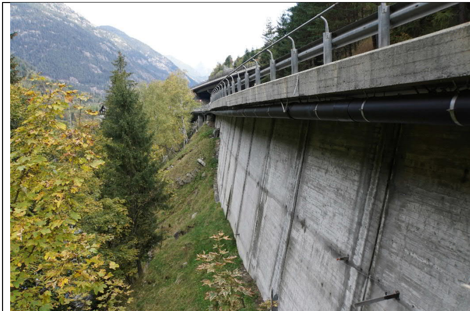
Talseitige Stützmauer zwischen Wassen und Göschenen. Durch die Auskragung werden die angehängten Werkleitungen verdeckt. Amsteg Göschenen (AG44)
