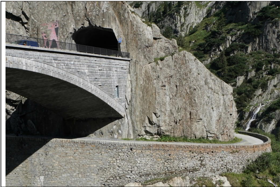
Tunnel Fadegg, Ansicht Portal Fahrtrichtung Göschenen Die Ausführung des Tunnels ist vergleichbar mit den Tunnelbauwerken am Sustenpass. Gotthardpass (G10)
