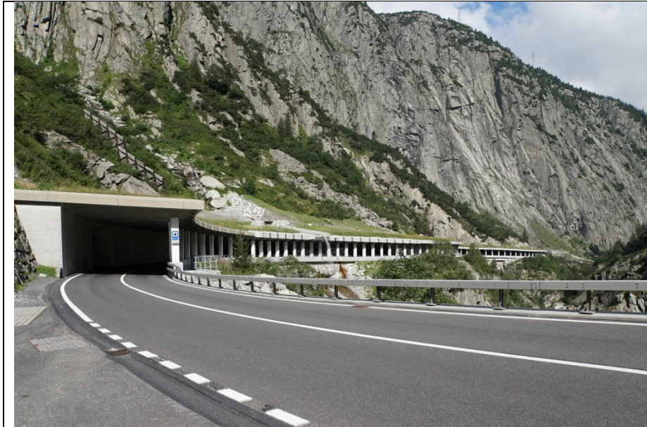
Galerie Tanzenbein, Ansicht Portal Fahrtrichtung Göschenen Gotthardpass (G8)
