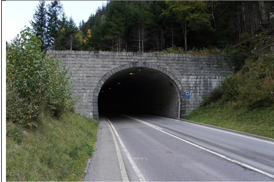
Tunnel bei Göschenen Ansicht Portal Fahrtrichtung Wassen Gotthardpass (G25)
