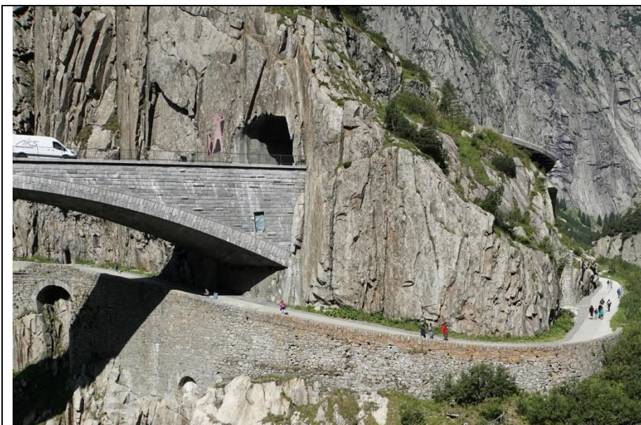
Tunnel Fadegg, Ansicht Portal Fahrtrichtung Göschenen Das Dach der Galerie Brüggwaldboden ist rückseitig erkennbar. Gotthardpass (G10)
