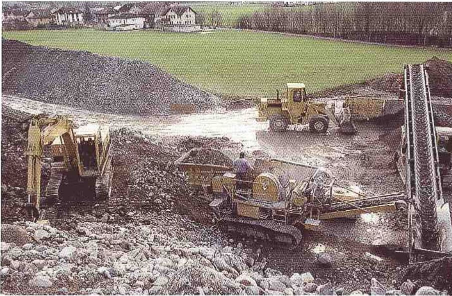
Brechen von Steinen und Aussieben zu Auflastfiltermaterial
