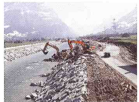
1 Verschiebung des Reussdammes (Bild: Irène Elber)
