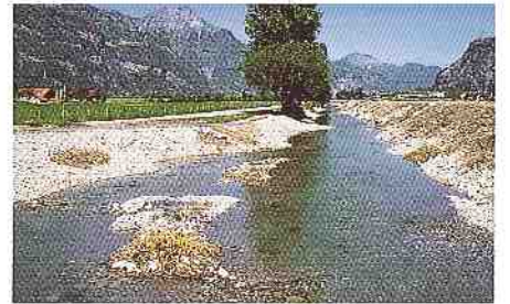
3.1, 3.2, 3.3 Giessen: vorher (links) – Bau (rechts) – nachher (oben)
