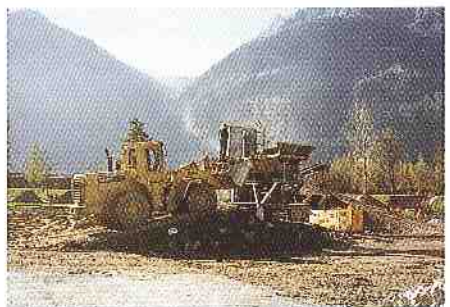
3 Einbau der tonwassergebundenen Deckschicht beim Wuhrweg
