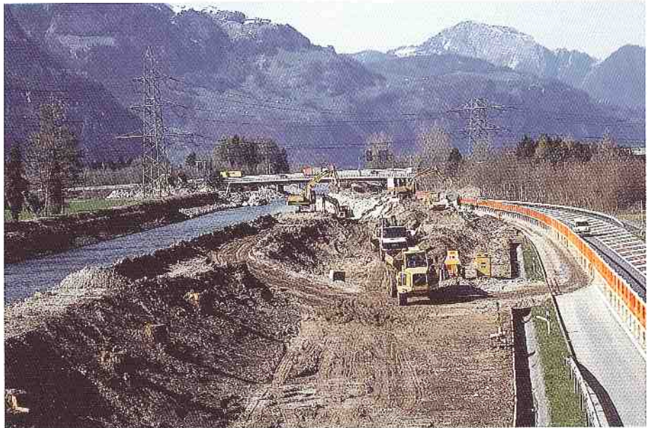
1 Verschiebung des Reussdammes (Bild: Irène Elber)
