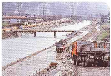
1 Konzentrierte Blocksatzarbeiten am linken Ufer in Attinghausen
