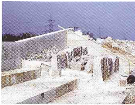
3 Entlastungsanlage Altdorf während des Baus (links)
