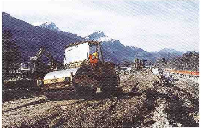
1 Klassischer Dammbau bei der Dammverschiebung unterhalb Brücke Seedorf
