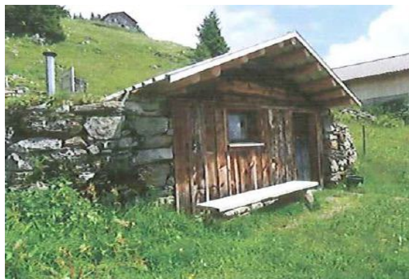
Sanierung und Teilersatzneubau
