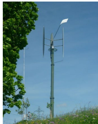
Typ «H-Darrieus» KWKA Rotorachse vertikal Feusisberg, SZ Gesamthöhe 15 m
