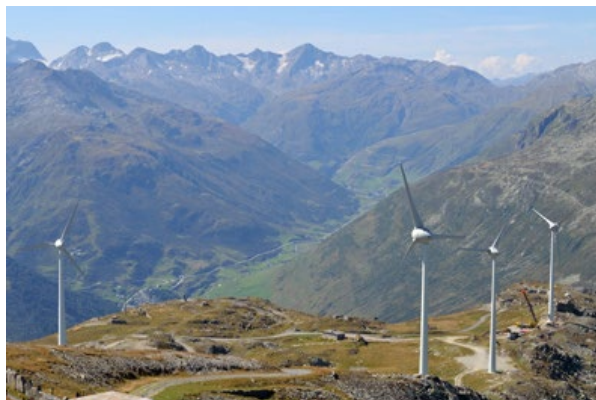
Typ «Windrad» Rotorachse horizontal Windpark, Gütsch ob Andermatt Nabenhöhe 55 m Gesamthöhe 77 m
