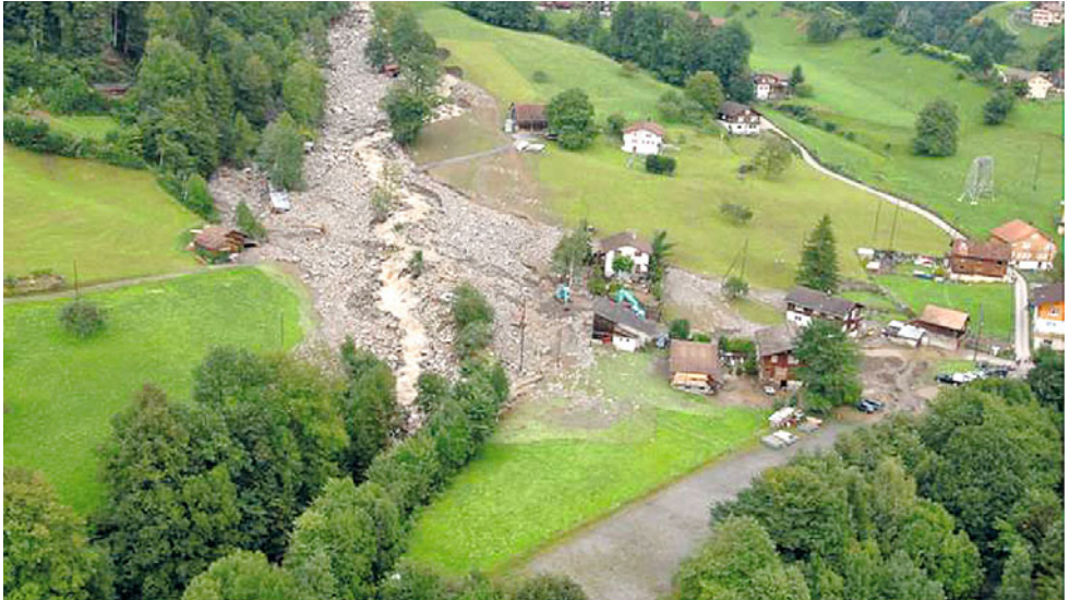
Bild der Zerstörung am Unterlauf des Holdenbachs (2005).
