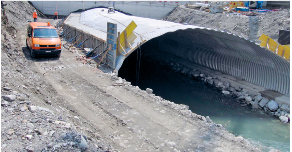
Schutz für den Urner Talboden: Verlegung und Verlängerung der Stillen Reuss.
