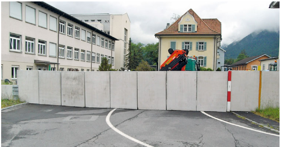
Sorgen schnell für Schutz: Betonelemente im Industriepark Schächenwald.
