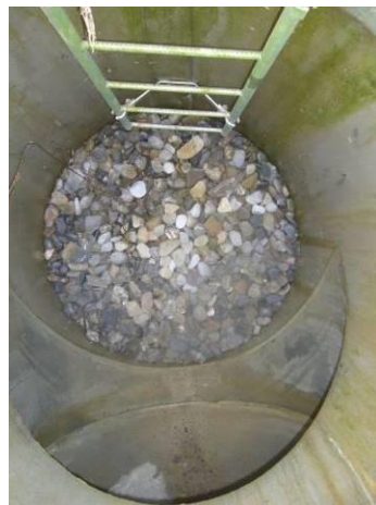
Sickerung mit Sickerkies
