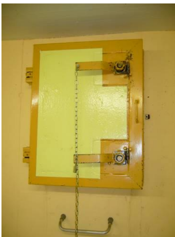
Panzerdeckel geschlossen mit Kette
