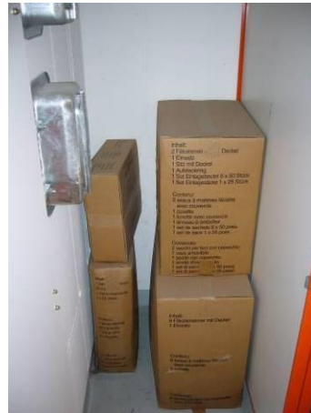
Abortkabinen mit Schutzraumausrüstung
