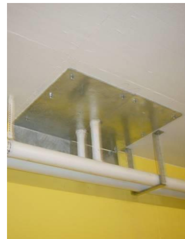
Heizleitung (Deckendurchführung)
