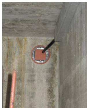
Wanddurchführung mit ein und mehreren Kabeln. Gas- und druckfesten Einlage (ab zwei Kabel zwingend)
