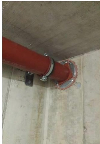
Wanddurchführung einer Wasserleitung (Abstellorgan ausserhalb)
