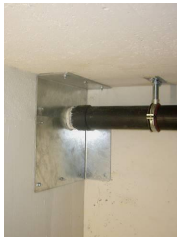
Dachwasserleitung (Wanddurchführung)
