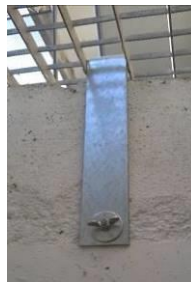
Notausstieg NA mit Gitter und Winkleisen
