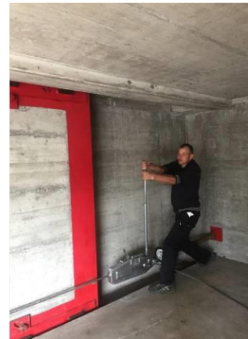
Panzerschiebewand (PSW) mit Seilzugapparat
