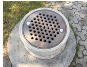
Fluchtröhre FR mit Gussdeckel und Kette
