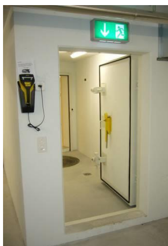
Panzertüre (PT1) mit betonierter Schwelle
