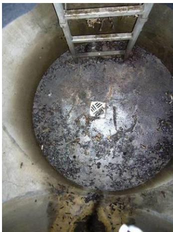
Sickerung mit Bodenablauf
