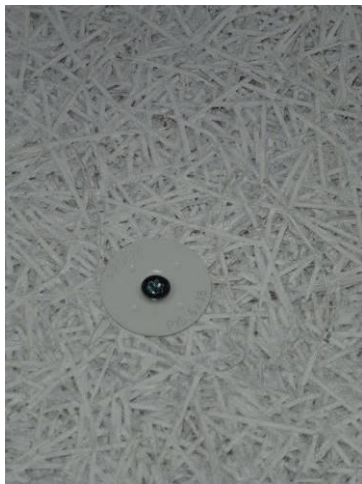
Deckendämmung geschraubt
