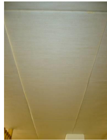
Deckendämmung mit Schienensystem
