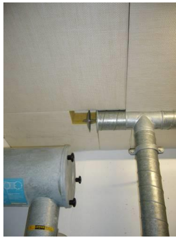
Deckendämmung punktgeklebt
