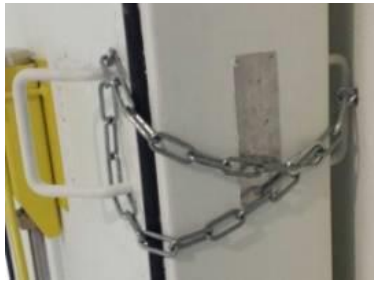
Panzertüre geöffnet mit Öse und Kette
