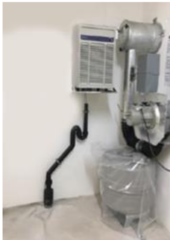
Entwässerung Luftentfeuchter
