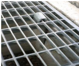
Notausstieg NA mit Gitter und Winkleisen
