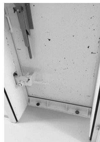
Panzertüre (PT1) mit demontierbarer Schwelle
