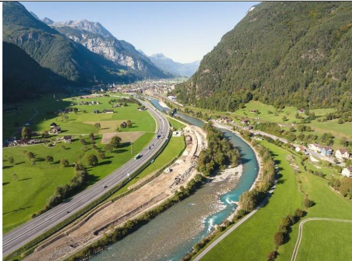
Der neue Damm sowie das Seitengerinne im Bereich des Walds wird erstellt sowie erste Strukturmassnahmen (Totholz, Wurzelstöcke) werden eingebracht. Grobe Steinblöcke wurden vom gefüllten Geschiebesammler Selderbach zugeführt und verwertet.
