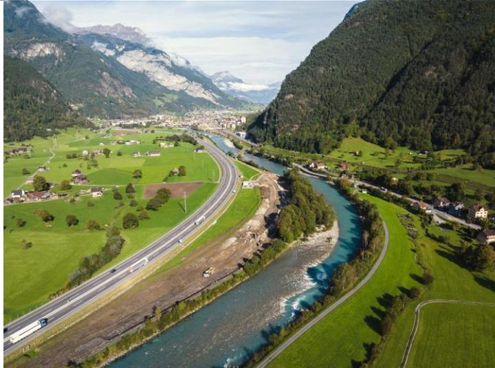
Der neue Damm sowie das Seitengerinne wurde im Bereich des Waldes erstellt sowie erste Strukturmassnahmen (Totholz, Wurzelstöcke) eingebracht. Grobe Steinblöcke konnten vom gefüllten Geschiebesammler Selderbach zugeführt und verwertet werden.
