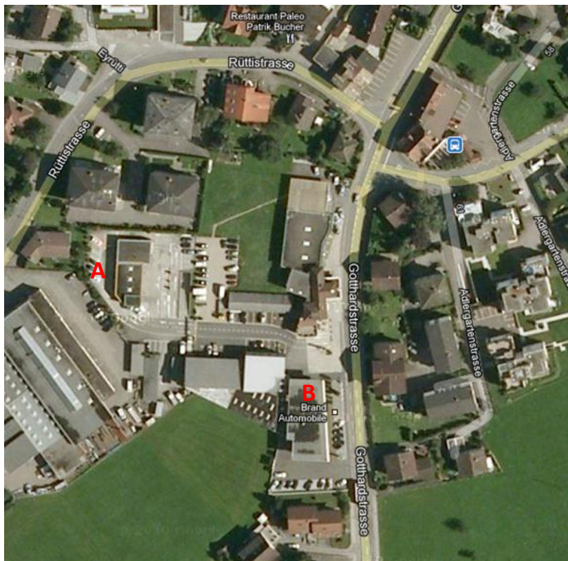
Abbildung 5: Übersicht Gelände Brand Automobile AG
