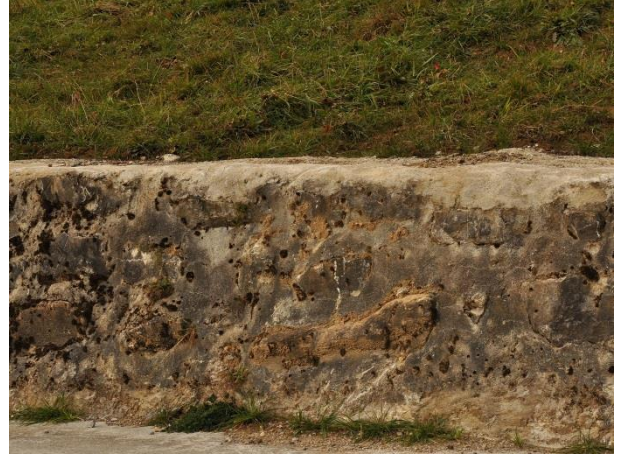
Betonierte, verfugte Stützmauer mit Natursteinen
