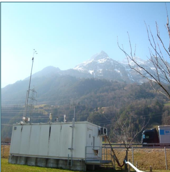
Abbildung 5: Messstation A2 Uri und deren Innenraum
