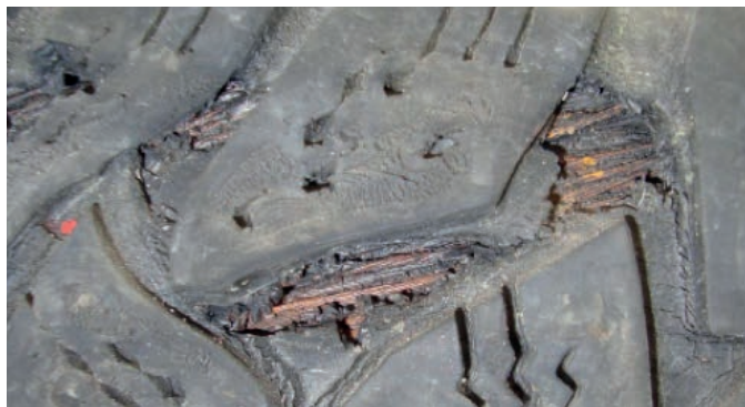
Stahlgürtel und Abdecklage sichtbar.
