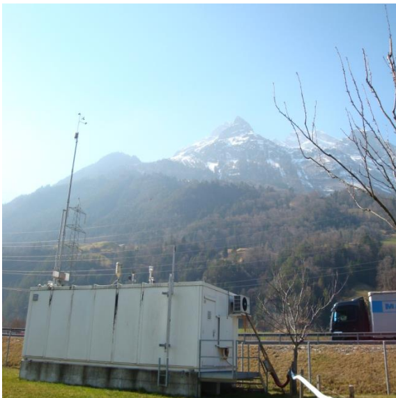
Abbildung 5: Messstation A2 Uri und deren Innenraum
