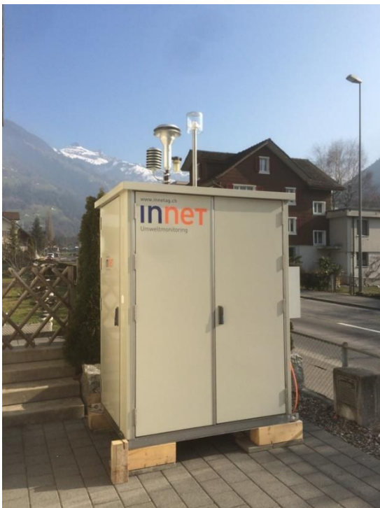
Abbildung 7: Messstation Schattdorf, Gotthardstrasse
