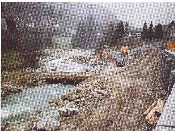
Bild 10. Bau-Furt nördlich der Wilerbrücke.
