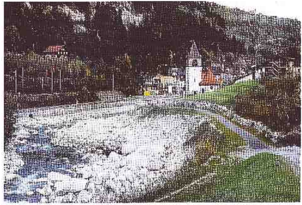
Bild 5. Hauptschutzelement B: Verdeckte Schutzmauer und Blockwurf oberhalb der Kirche.
