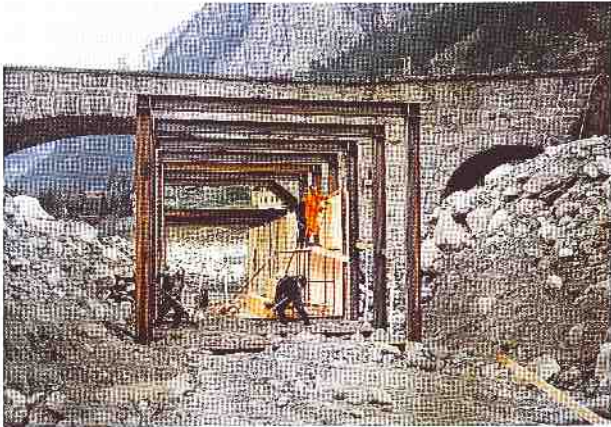
Bild 4. Erstellung Umleitkanal für Abflüsse von bis zu 150 m 3 /s.
