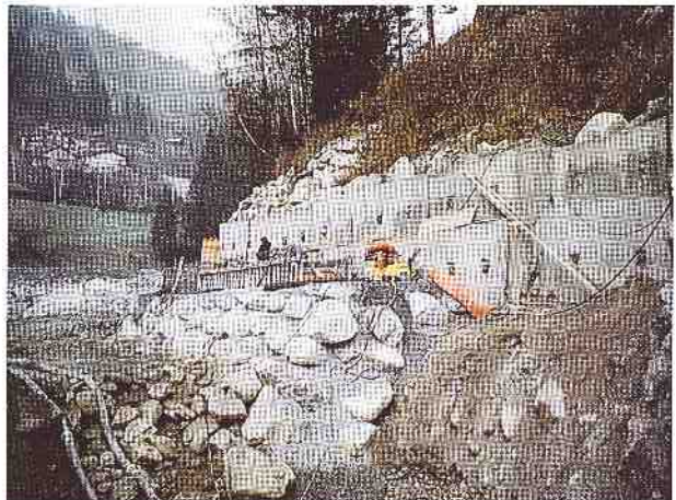
Bild 11. Gewicht-/Winkelstützmauer nördlich des Steintals.
