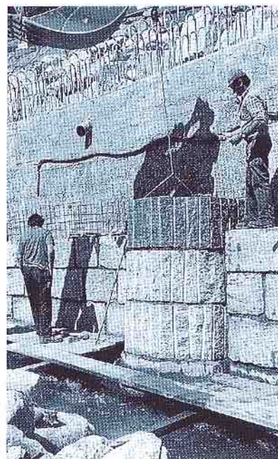
Bild 7. Aufbau einer Rauheitsrippe 1992.
