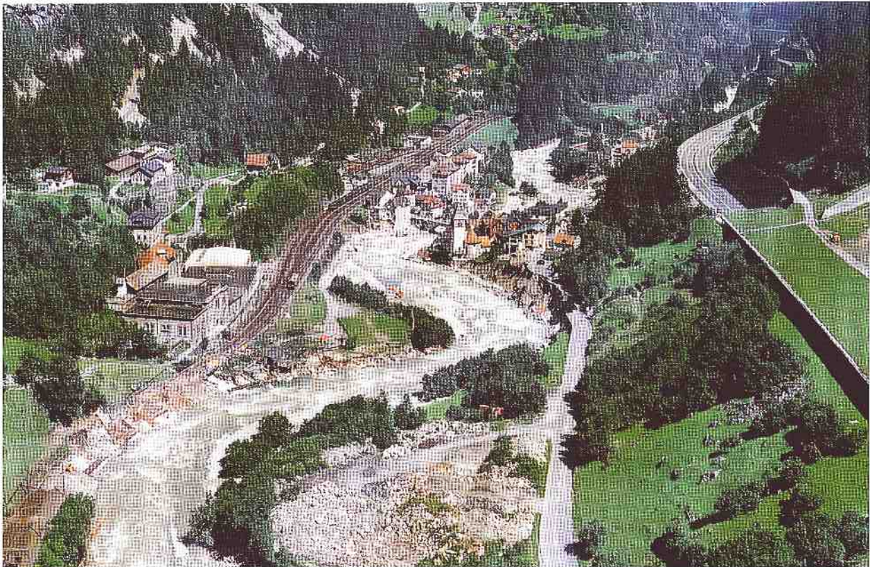
Bild 4. Hauptschäden südlich der Wilerbrücke.
