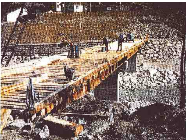
Bild 2. Erstellung der Baubrücke südlich Kirche.
