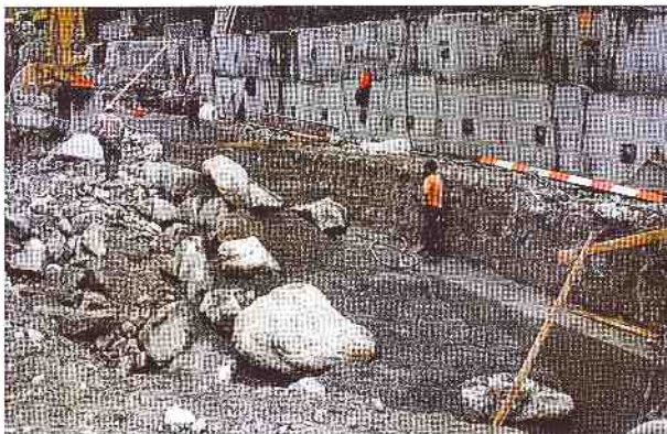
Bild 7. Hauptschutzelement C. 2fach verankerte Elementwand unterhalb der SBB-Stützmauer. Gewichtsmauer, etappenweise ausgeführt; Integrieren einer alten Bruchsteinmauer, welche beim Aushub zum Vorschein kam.
