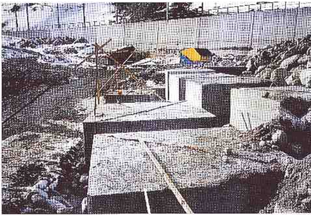
Bild 4. Hauptschutzelement A: Am Rande der Halbinsel eingegrabene diagonal halbierte Betonwürfel (Kantenlänge 2,75 m).
