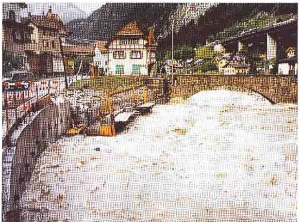
Bild 12. Hochwasserabfluss vom Juni 1992.
