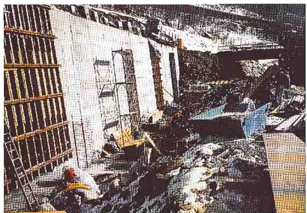
Bild 8. Betonmauer Bauteil 19 Kirche Süd.
