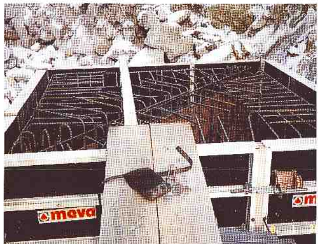
Bild 5. Hauptschutzelement B. Künstliche Residualblöcke in Form von diagonal halbierten Betonwürfeln.
