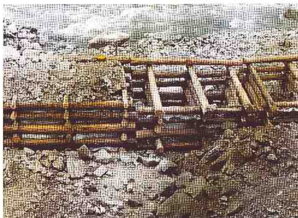
Bild 10. Krainerwand im Bau.
