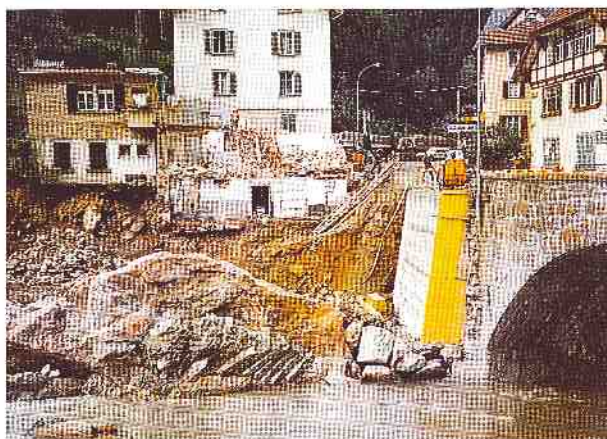
Bild 8. Unterfangung linkes Widerlager Wilerbrücke.
