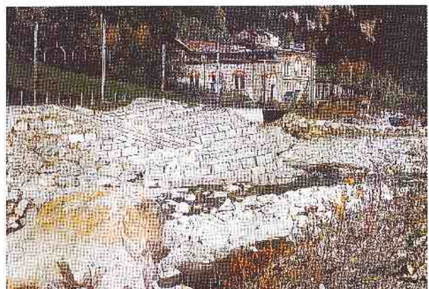
Bild 3. Hauptschutzelement A: Ansicht des Umlenksporns vom Oberwasser.
