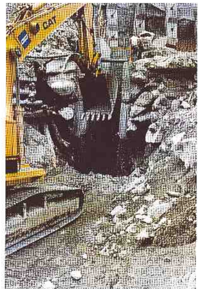
Bild 4. Hauptschutzelement B. Schachtaushub.
