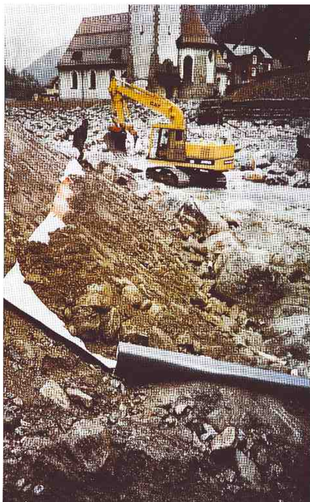
Bild 3. Abdichtung Schutzdamm mit Folie; Kolk-schutz-Blöcke.
